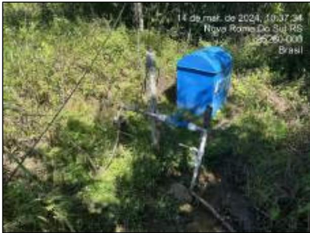
Figura 7 – Caixa d'água de 10.000 L que irá receber a água do novo poço a ser perfurado.
